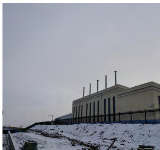
中心医院供热站
