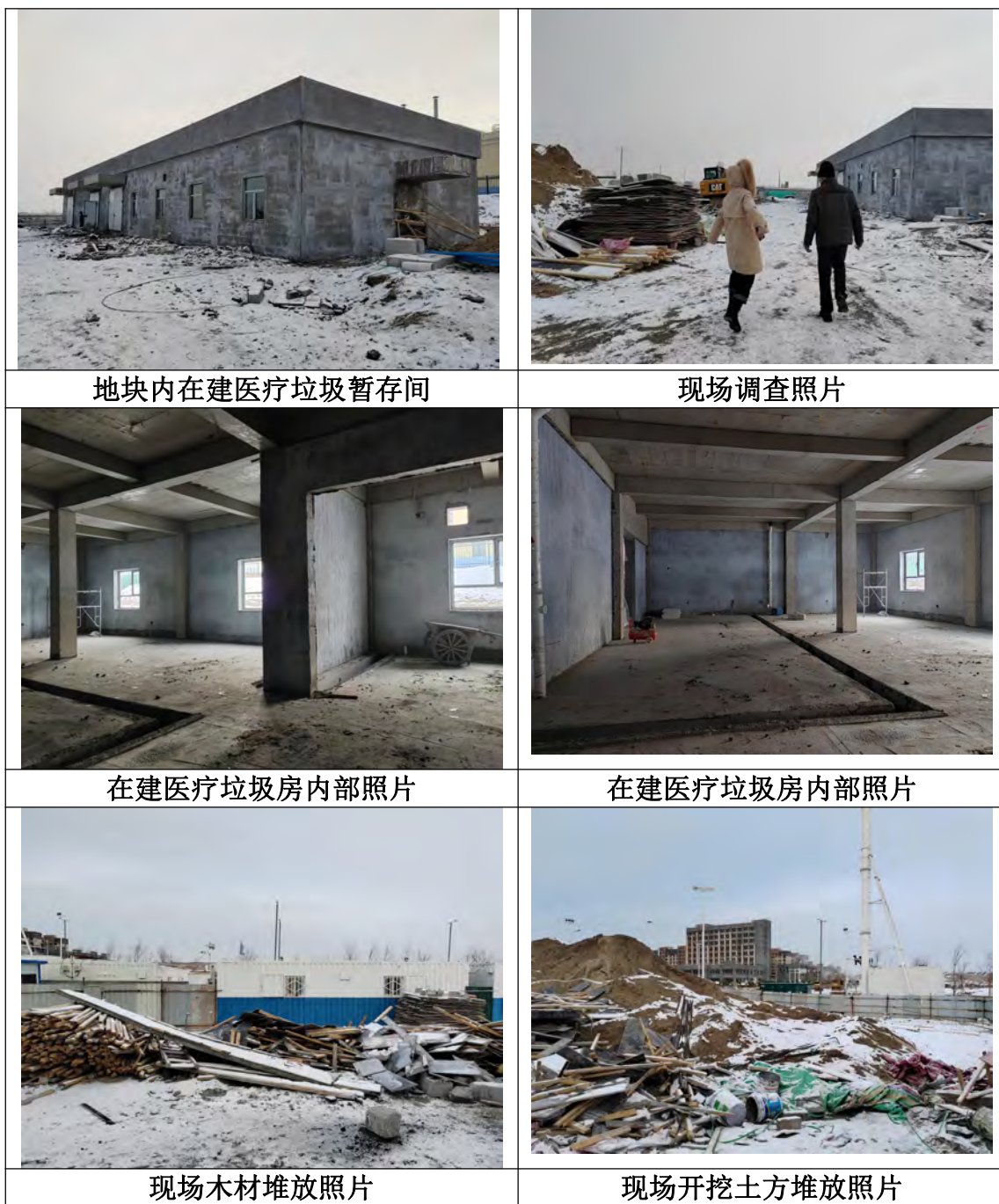
图 3-5 地块内现状照片
