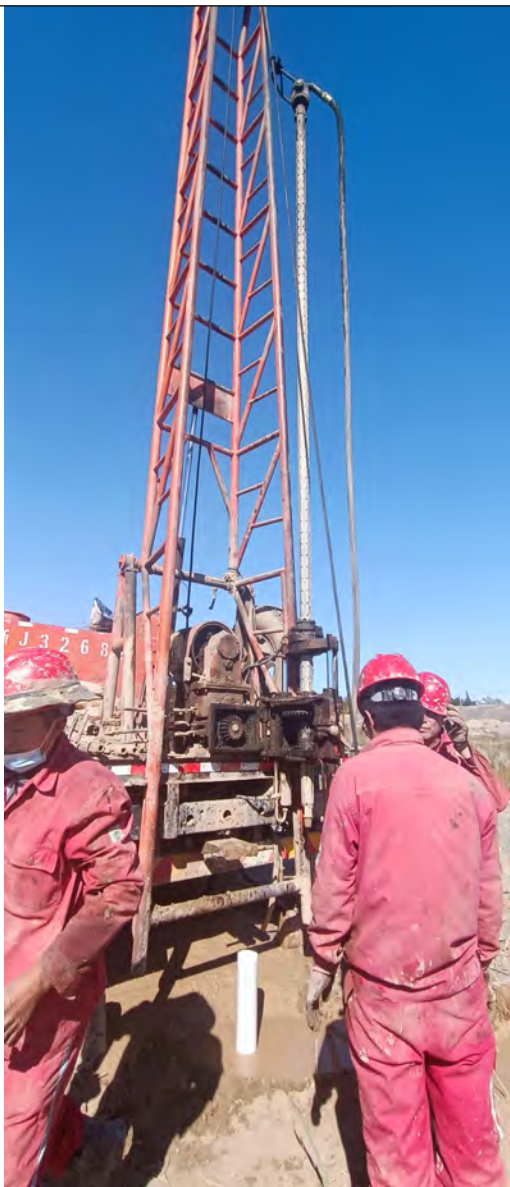
地下水井建设
