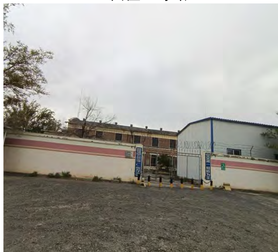
采油一厂二零五注水站
