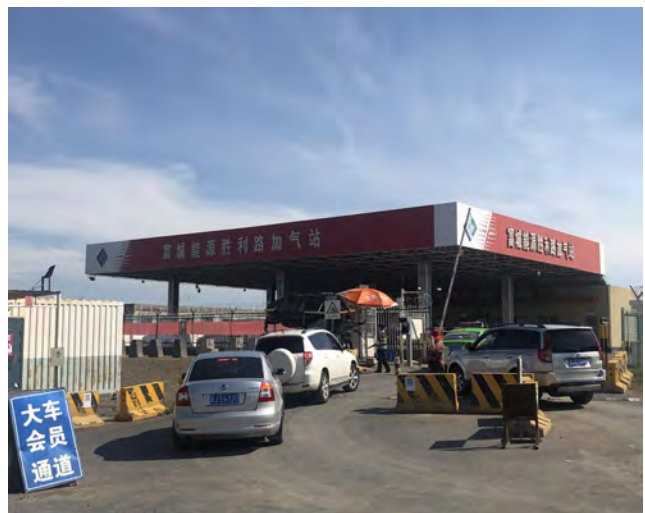
富城能源加气站
