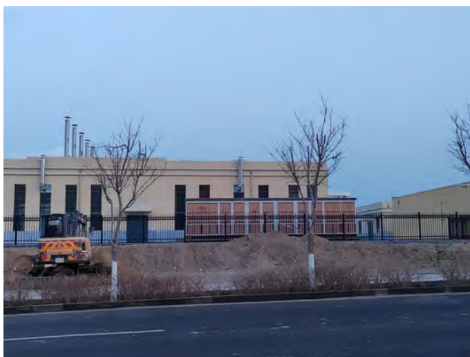
中心医院供热站
