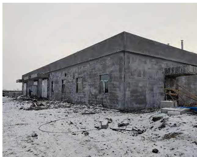
中心医院医疗废物暂存间（在建）
