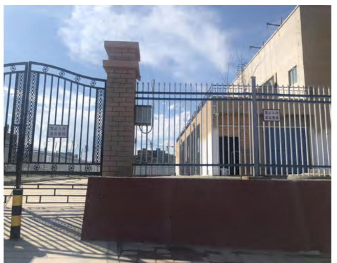
城南变配电站
