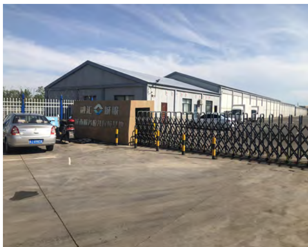
融汇城服应急保障基地
