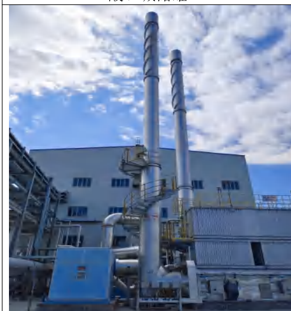
RTO 氧化炉及排气筒（依托）
