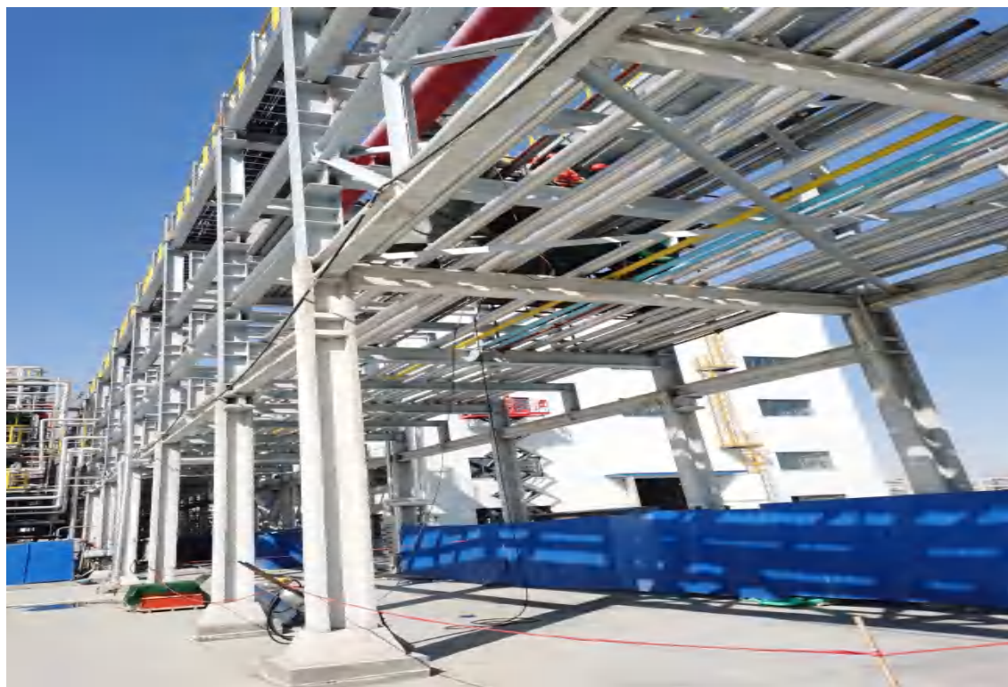
施工期围挡照片
