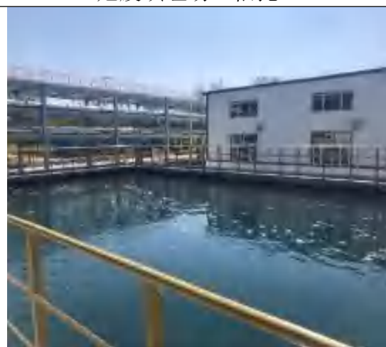
2#工业水场污水处理站（依托）
