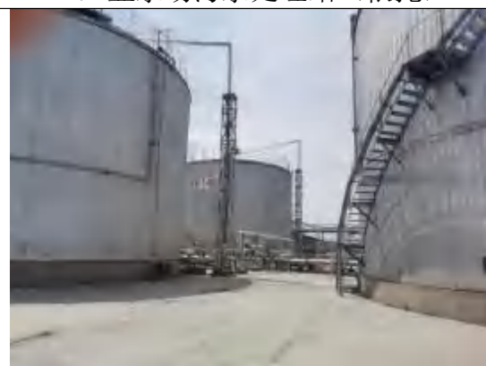
原有罐区（依托）
