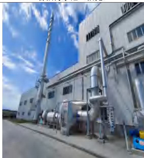
后处理卷帘式过滤器及排气筒（依托）
