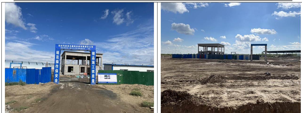
地块二期项目现状照片
